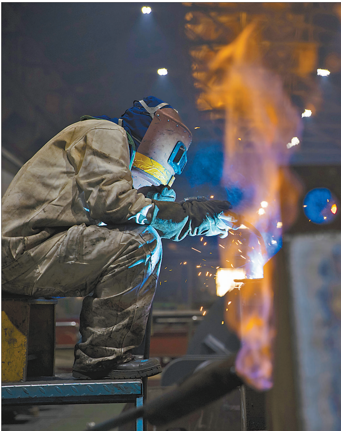
3月23日,黑龙江省哈尔滨市,工人在哈电集团哈尔滨电机厂有限责任公司生产车间内进行焊接作业。在做好疫情防控的前提下,哈尔滨市规上企业坚持防疫、生产“两不误”,保质保量完成订单,力争最大限度减少疫情对经济社会发展的影响。
