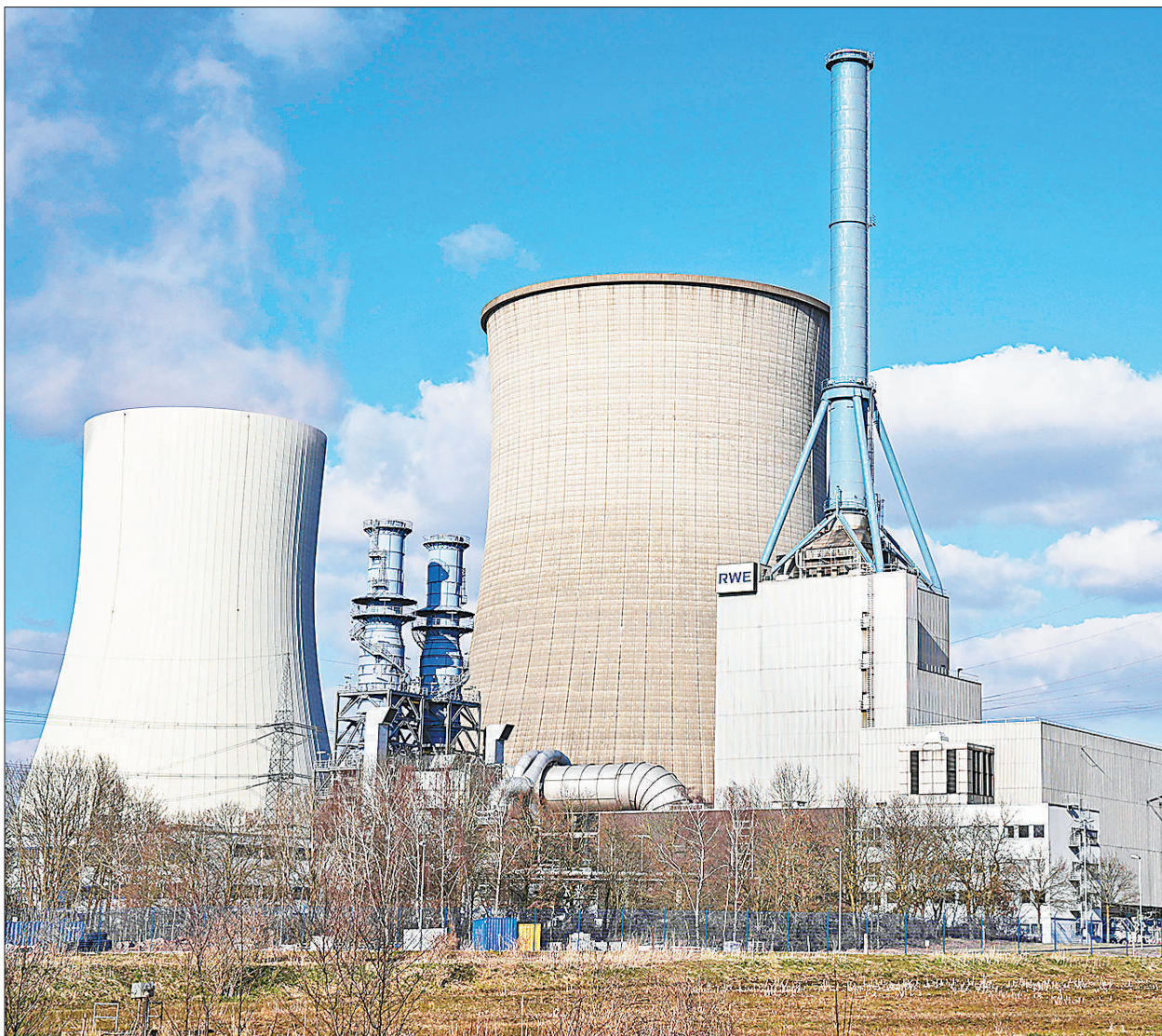
欧洲媒体近日报道,德国计划到2035年,用可再生能源满足所有发电需求。目前,德国天然气发电占比约为16%。图为3月18日在德国林根拍摄的天燃气发电站。
