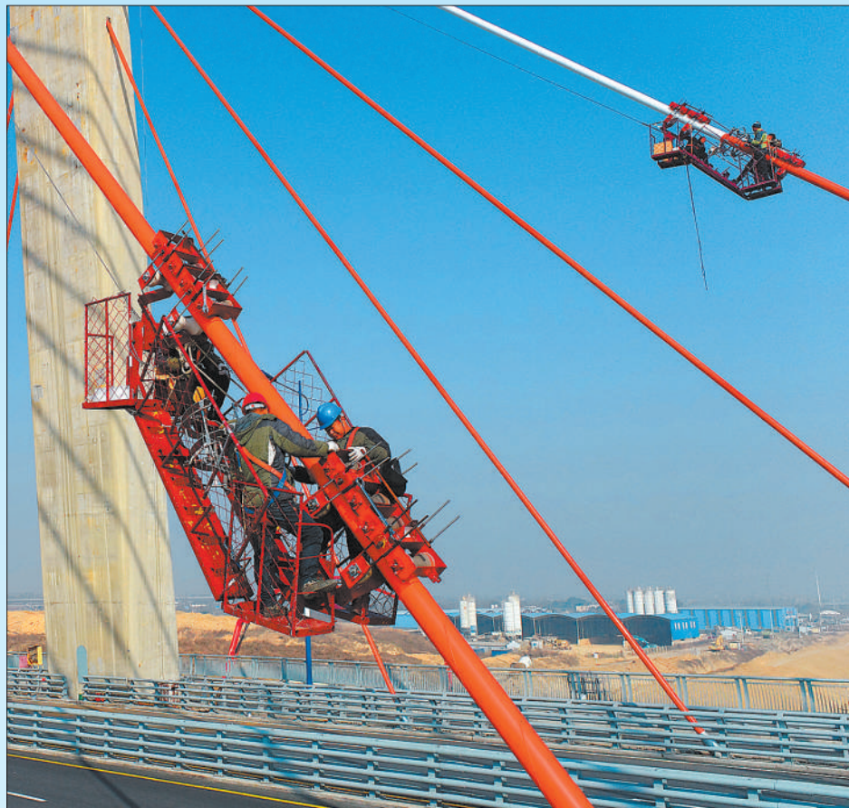
图②：工人在位于安徽省合肥市庐江县的引江济淮文昌西路大桥上安装斜拉索防护带。王 阔摄(影像中国)
