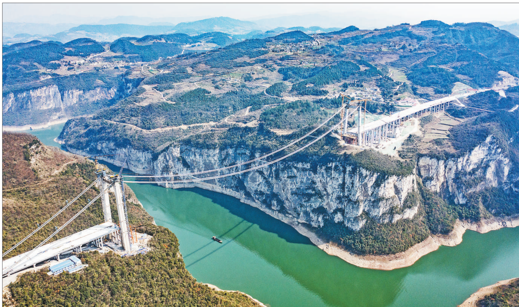
金峰乌江大桥是贵州贵阳经金沙至四川古蔺高速公路项目的重要控制性工程，桥梁全长达1473.5米，预计2022年底建成通车。目前，金峰乌江大桥建设进展顺利。
