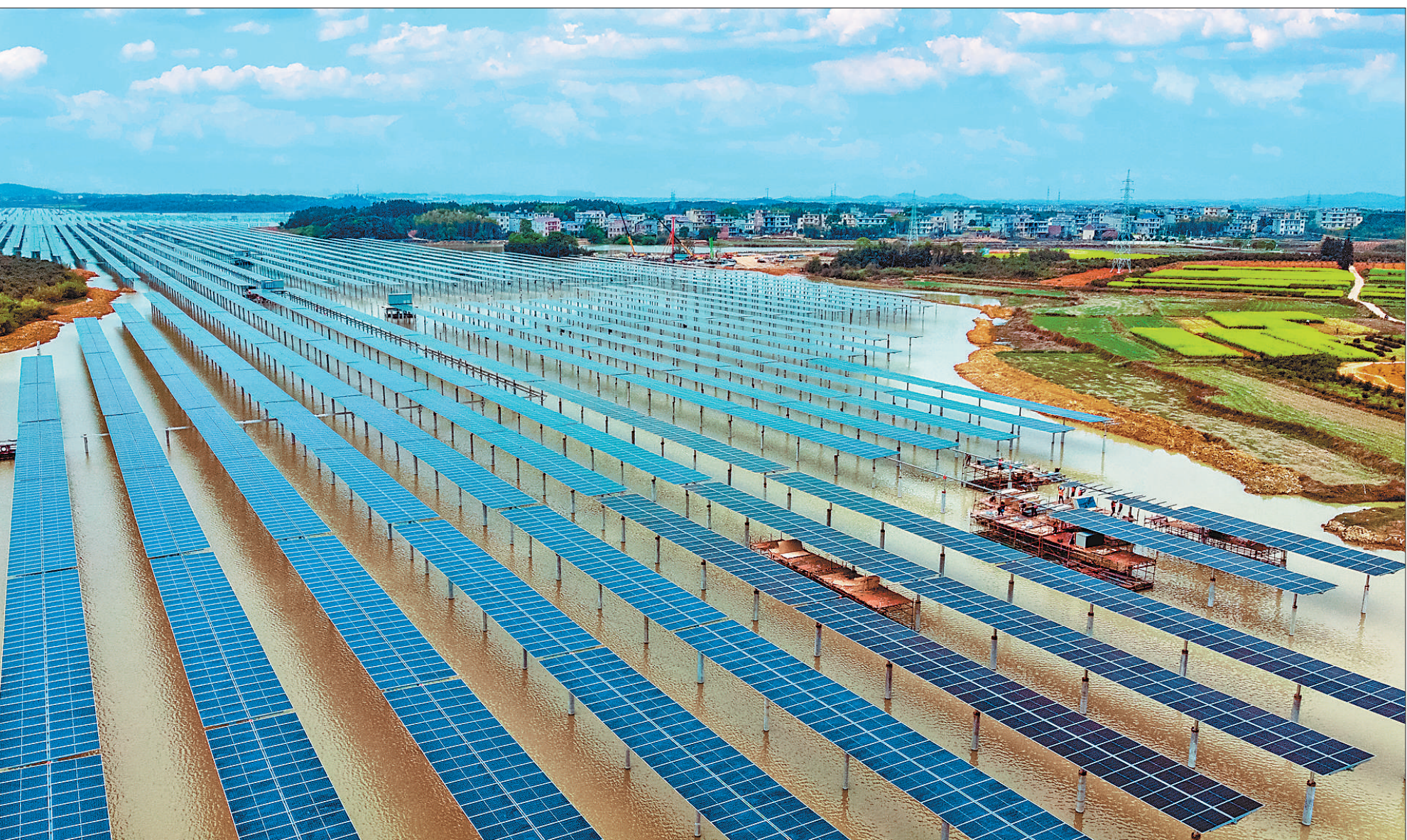
3月16日,江西省上饶市余干县大溪乡神岭水库,150兆瓦“渔光互补”集中式光伏电站项目现场一派繁忙景象,施工人员在安装发电设备。据介绍,该项目将于今年5月完成并网发电,建成后预计年均上网电量达2.5亿千瓦时。
