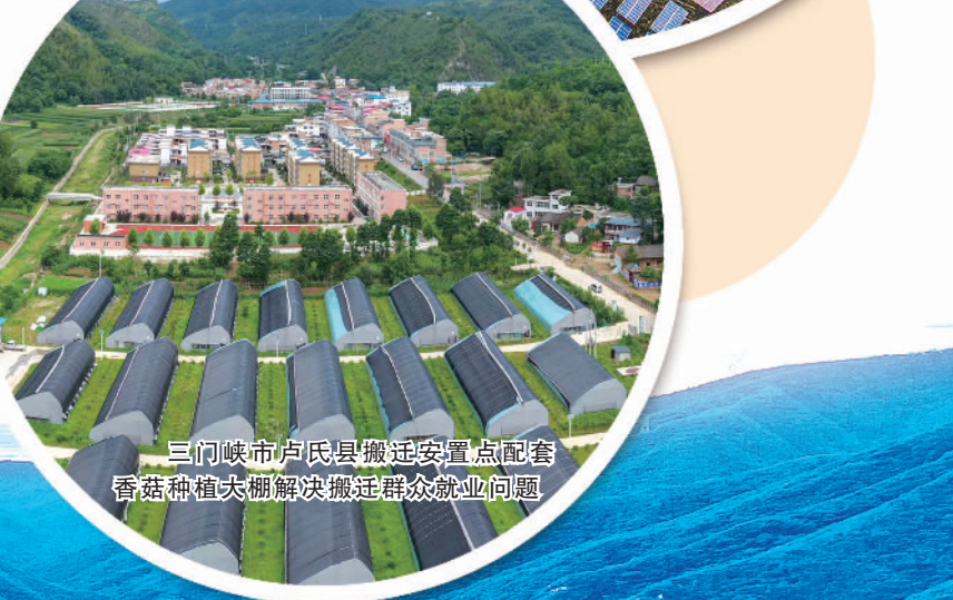
南阳市南召县城乡史庄村光伏电站
