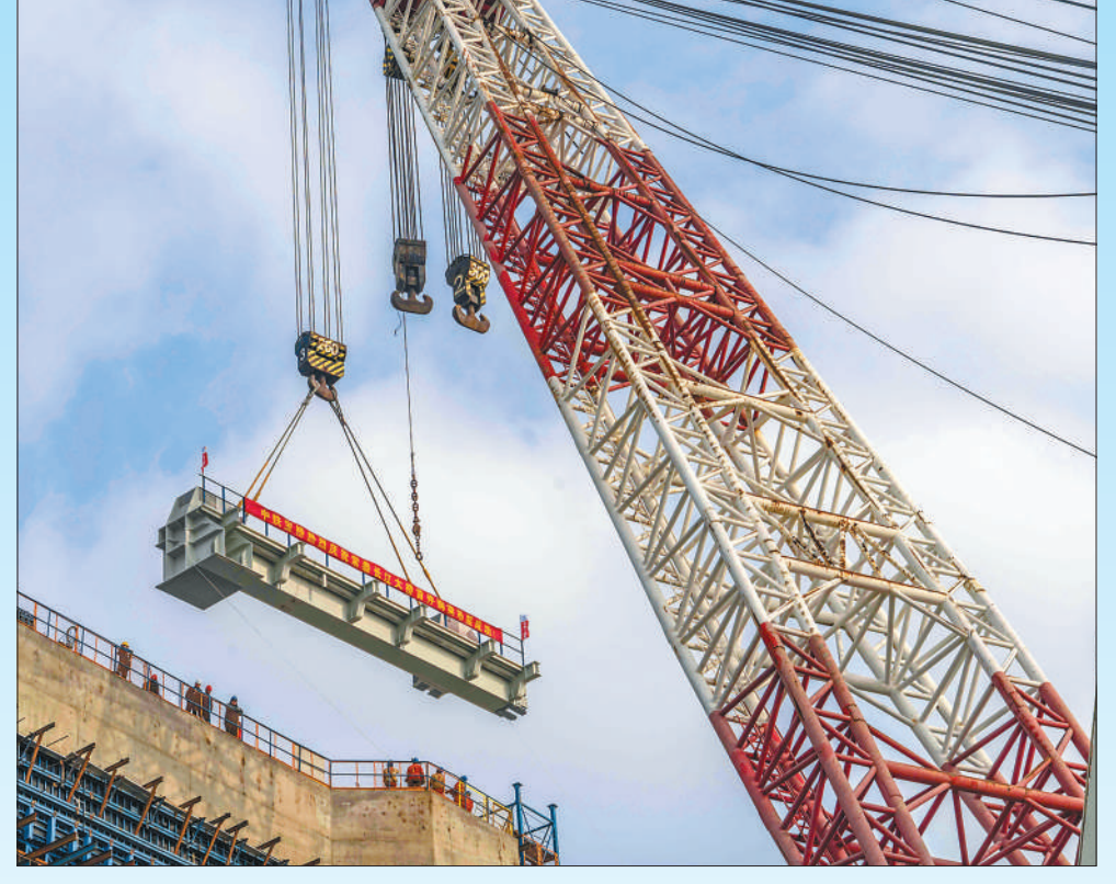
图①：深中通道是集“桥、岛、隧、水下互通”于一体的超级跨海集群工程，其中桥梁工程长约17.2公里。图为在广州南沙区万顷沙南侧的深中通道正加紧建设。魏劲松摄（影像中国） 图②：常泰长江大桥天星洲航道桥首节段钢梁已顺利吊装。天星洲航道桥主跨388米，为世界最大跨度双层钢桁梁拱桥。图为工人对天星洲航道桥首节段钢梁进行吊装。汤德宏摄（影像中国） 图③：位于安徽庐江的引江济淮文昌西路大桥，是连通庐江县城与高铁庐江西站的重要桥梁。图为施工人员在安装斜拉索防护带。王 闽摄（影像中国） 图④：贵南高铁是我国“八纵八横”高速铁路主通道包头至海口通道的重要组成部分。图为贵南高铁（贵州段）营盘清水河双线特大桥建设场景。新华社记者 杨文斌摄 图⑤：中国首条跨海高铁——新建福州（州）厦（门）铁路木兰溪特大桥斜拉桥主梁顺利合龙。图为工人在合龙现场施工。周 义摄（新华社发） 图⑥：位于浙江省宁波市的杭甬复线滨海互通立交桥首层G匝道第五联钢—混凝土叠合梁，已架设完成。该桥建成后将成为亚洲最大的海上互通立交桥。图为建设中的杭甬复线滨海互通立交桥。胡学军摄（人民视觉）
