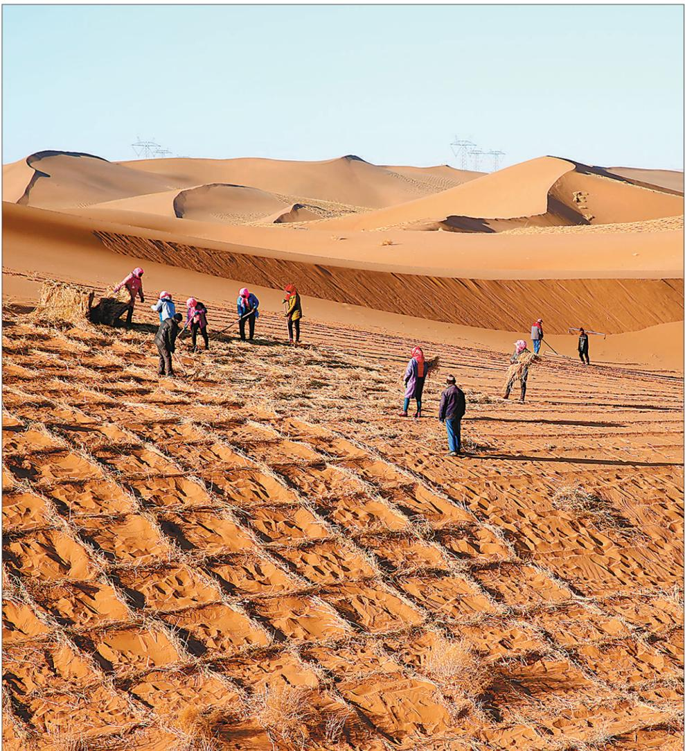
2月28日，在甘肃省张掖市临泽县平川镇，治沙人员正在用麦草建设阻沙网。临泽县位于巴丹吉林沙漠边缘，沙漠戈壁占全县总面积的2/3以上。多年来，该县坚持防沙治沙，筑牢生态安全屏障，做强红枣、葡萄等特色林果产业，助力农民增收。据了解，临泽县今年将治沙近万亩，目前阻沙网建设已完成90%。
