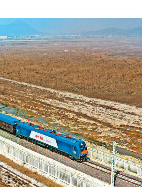
2月28日,“义新欧”中欧班列“台州号”在浙江台州临海头门港站首发。此趟首发班列满载新能源汽车零部件、电动自行车配件、休闲用品和水暖管道配件等出口产品,将于23天后抵达德国杜伊斯堡。潘俊俊摄(影像中国)
