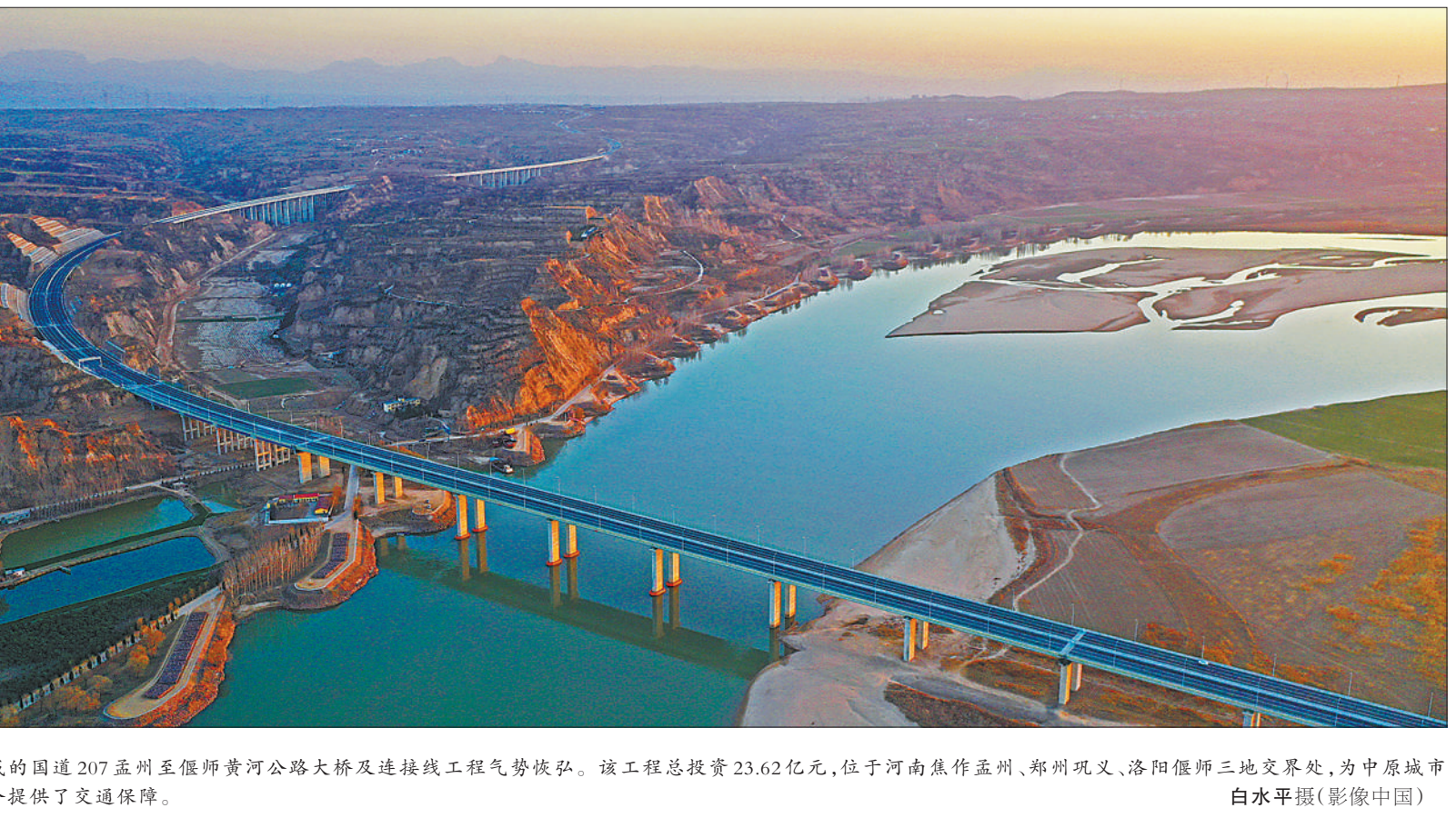
新建成的国道207孟州至偃师黄河公路大桥及连接线工程气势恢弘。该工程总投资23.62亿元,位于河南焦作孟州、郑州巩义、洛阳偃师三地交界处,为中原城市群协作融合提供了交通保障。
