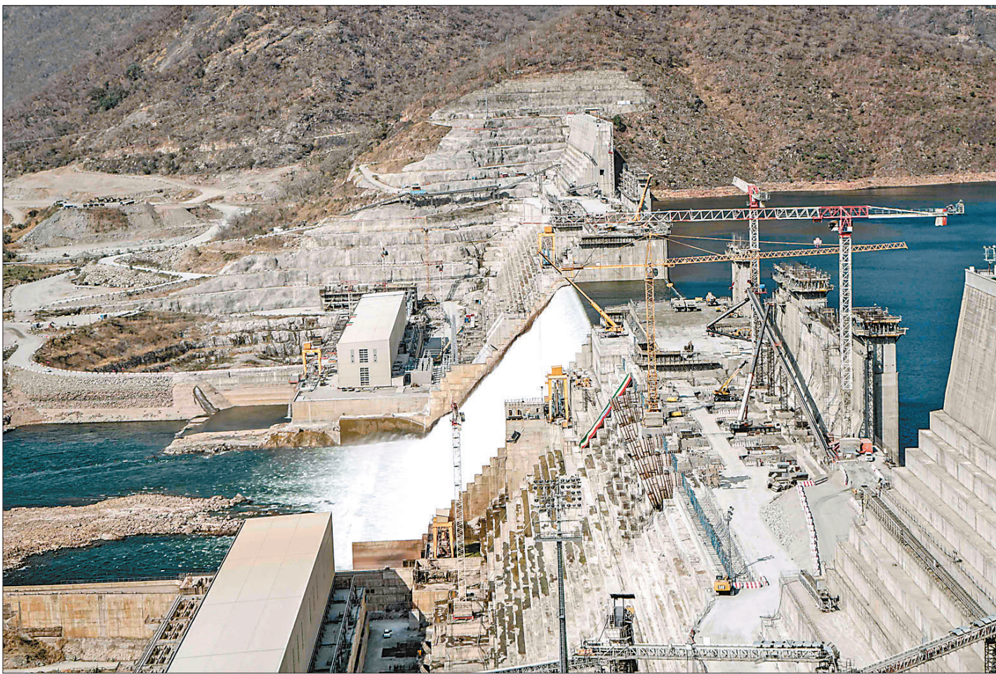
2月20日,位于埃塞俄比亚西部的复兴大坝部分机组正式发电。大坝全部完工还需3年左右时间,届时装机容量将超过5000兆瓦,成为非洲最大的水电站。图为复兴大坝全景。
