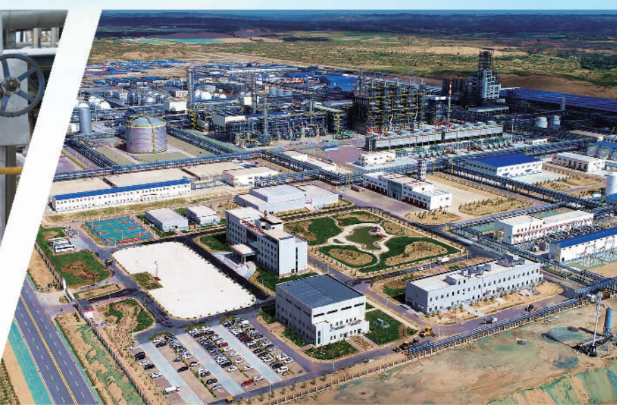
兰州石化乙烷制乙烯装置
