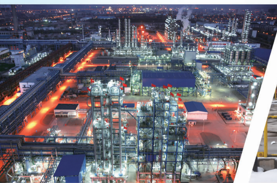
兰州石化46万吨/年乙烯装置夜景
