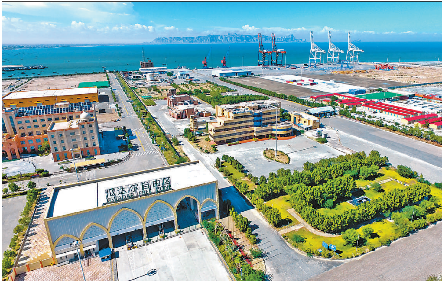
图为建设中的巴基斯坦瓜达尔自由区。
