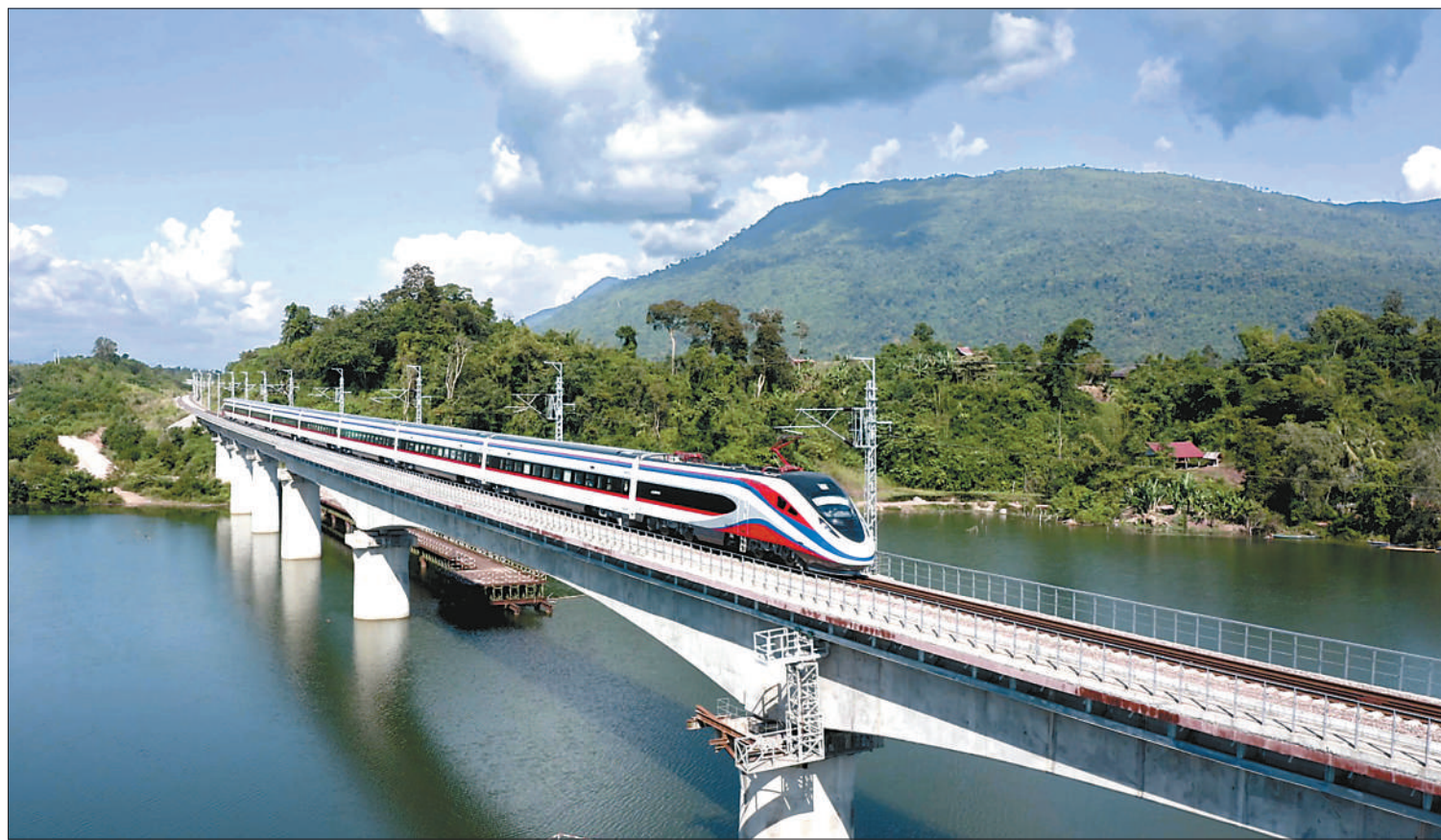
中老铁路“澜沧号”动车组行驶在位于老挝万象省的欣合楠里河特大桥上。
