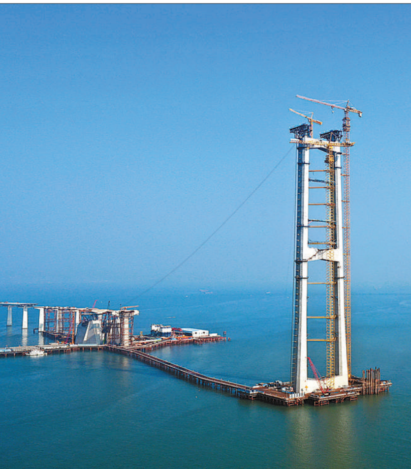
2月15日,深中通道伶仃洋大桥先导索顺利过江,为深中通道2024年建成通车打好基础。伶仃洋大桥是深中通道关键控制性工程之一,主跨长1666米,主塔高度为270米,为世界最大跨径全离岸海中钢箱梁悬索桥。图为伶仃洋大桥先导索顺利过江。贺利平 张政摄影报道(人民视觉)
