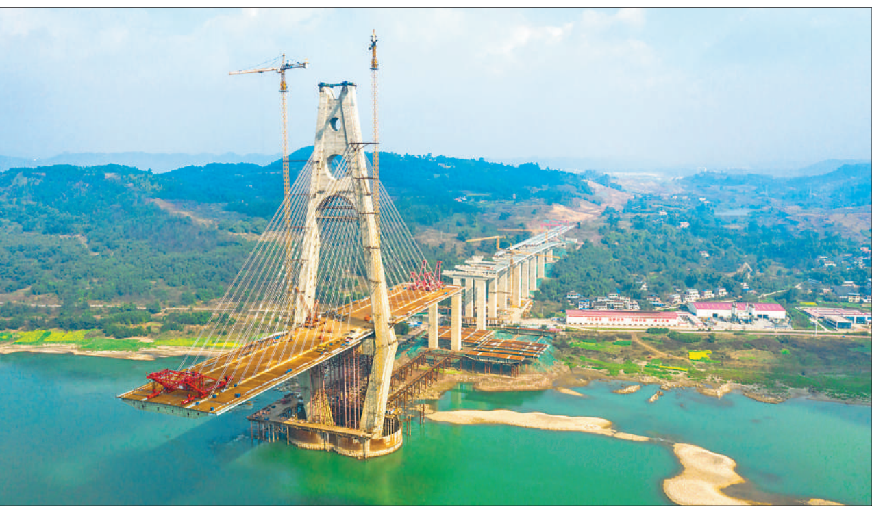
春节假期后,各地重点项目建设稳步推进。目前,四川宜宾临港公铁两用长江大桥正加紧施工,力争今年年底完成主体工程。大桥全长1742.1米,是川南城际铁路自贡至宜宾线高铁的控制性工程,是国家“八纵八横”高铁网中渝昆高铁、蓉昆高铁过江通道。 图为2月13日拍摄的建设中的宜宾临港公铁两用长江大桥。 严易程摄(影像中国)
