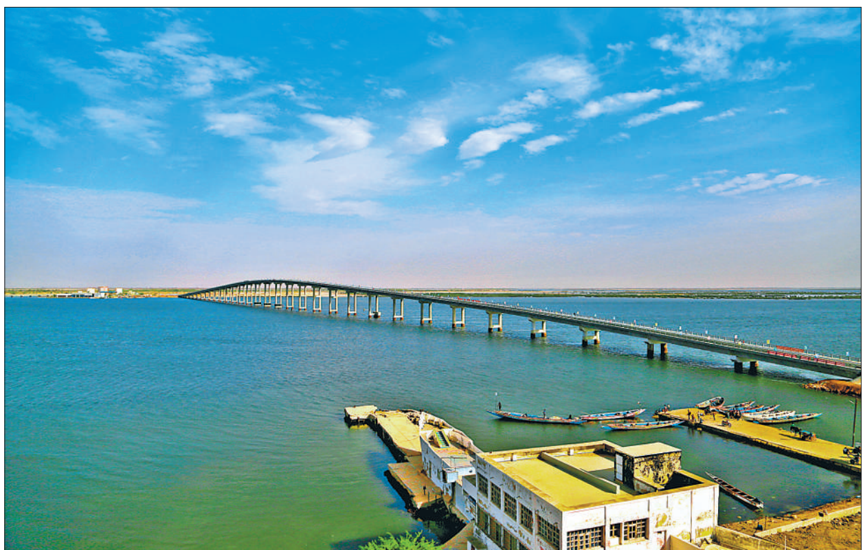
近日，历经3年多紧张施工，由中国企业承建的塞内加尔方久尼大桥正式开通。该项目是“塞内加尔振兴计划”优先重大项目之一，也是中方积极落实中非“十大合作计划”的具体体现。作为塞最长桥梁，大桥成为连接该国南北方主干道之一，也是前往邻国的重要交通节点。新华社发
