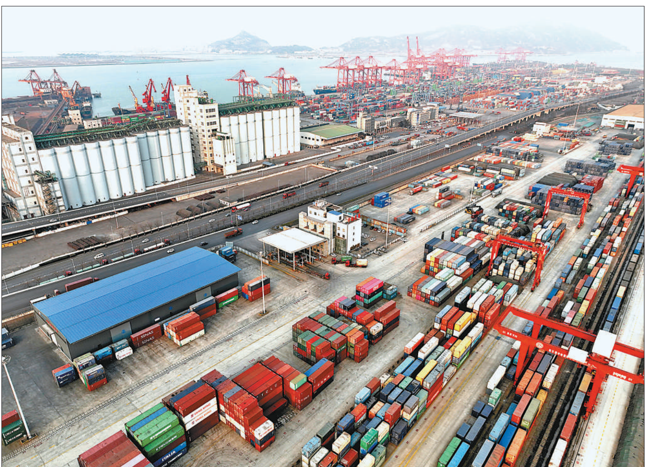
2月8日,一列满载日用品、办公用品、机械设备等货物的班列从江苏连云港中哈物流合作基地发出,驶往哈萨克斯坦、乌兹别克斯坦、吉尔吉斯斯坦等中亚国家。图为在连云港中哈物流合作基地内,大型机械正在向列车装载集装箱。
