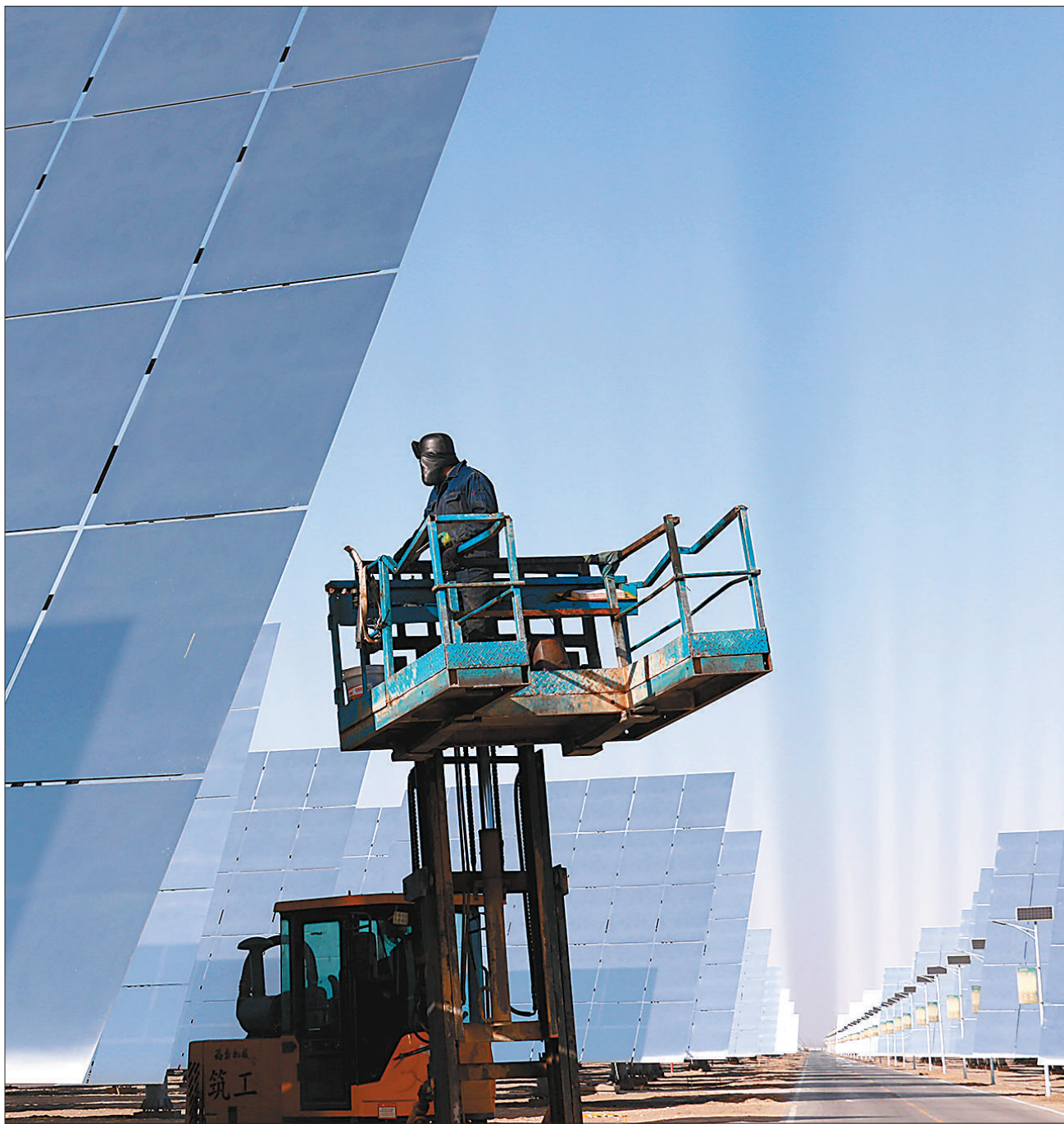
2月8日,甘肃省敦煌市光电产业园区,工人在检查设备运行情况。近年来,敦煌市依托优越的风光资源,建设光电产业园区,大力发展新能源产业。去年光电产业园区新能源发电量达18.1亿千瓦时,销售收入15.6亿元,同比分别增长28.8%和39.3%。 张晓亮摄(影像中国)
