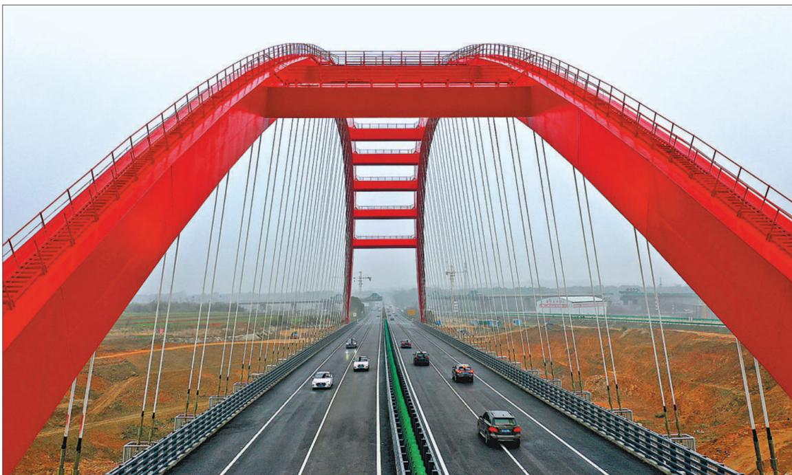
1月25日，安徽省合肥市庐江县境内引江济淮G3合铜黄高速特大桥竣工通车。主桥为钢箱梁提篮拱桥，跨度295米，居安徽省同类桥梁前列。 柳晓华摄（影像中国）
