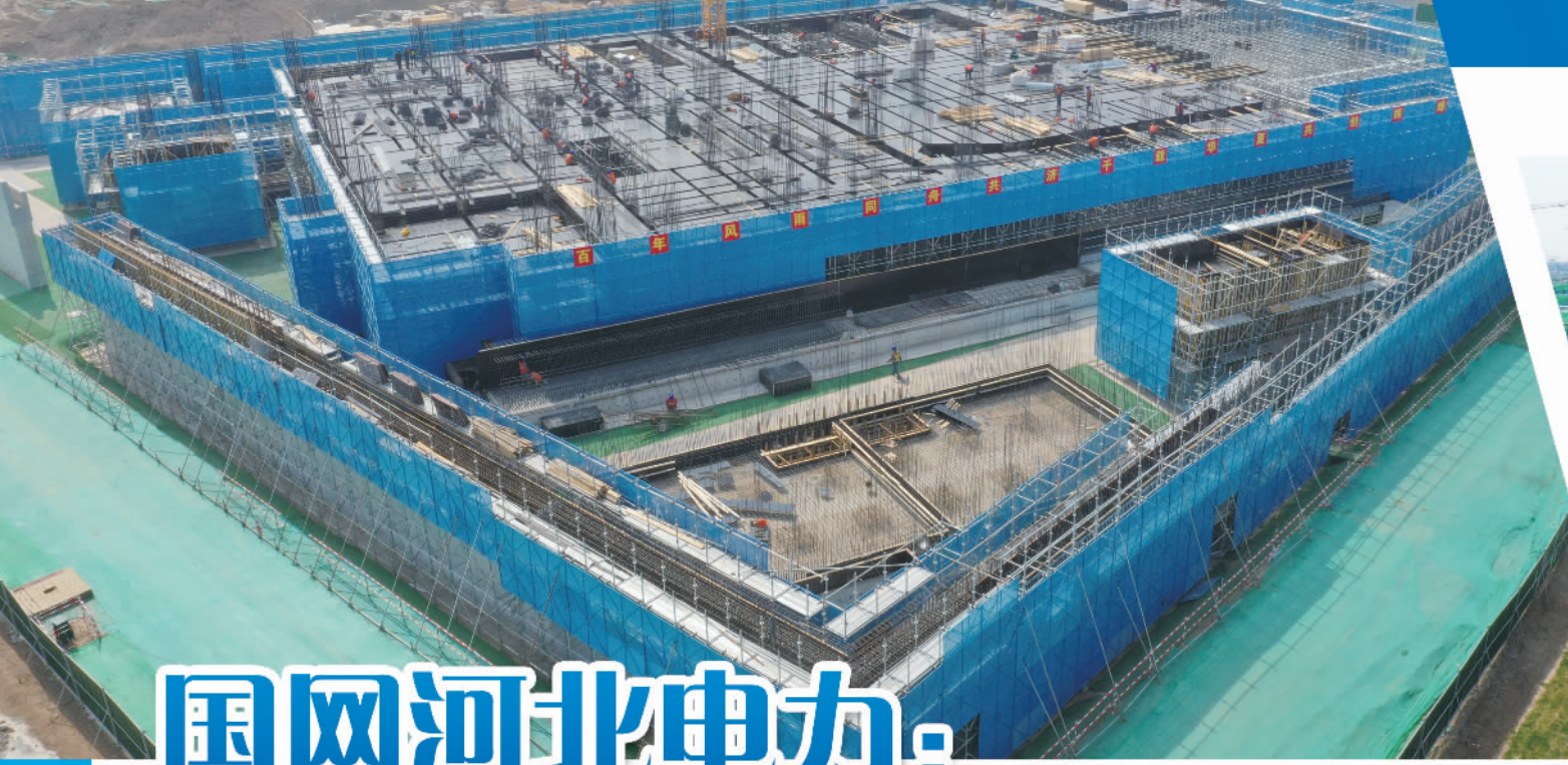
雄安管西220千伏变电站综合配电网建设现场
