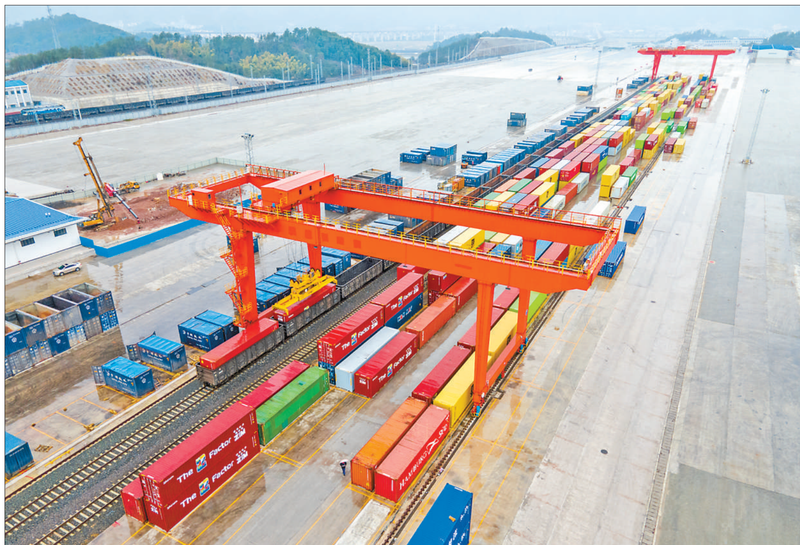
1月22日，浙江省铁路金华永康东站，大型吊机正在将满载电动工具等五金产品的集装箱装入列车车厢。当天，这趟海铁联运班列开往宁波北仑港，随后通关登船出海。胡肖飞摄(影像中国)
