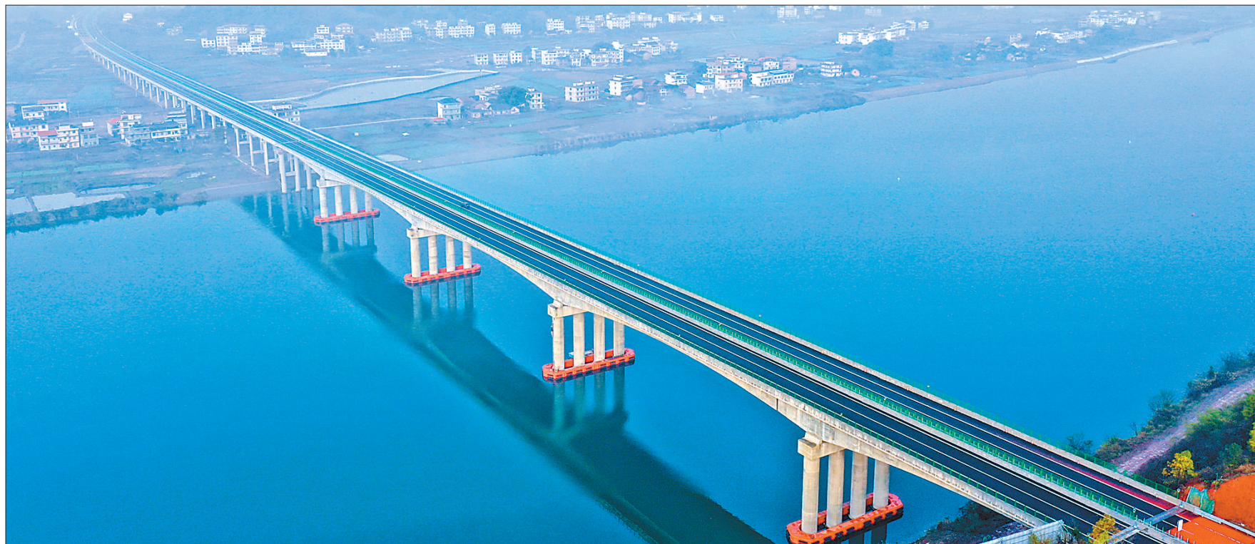
湖南省常德(常德)祁(祁东)高速公路日前顺利通车，对完善当地高速公路网、提升区域通行能力起到积极作用。图为常德祁高速公路石潭湘江特大桥。(周秀鱼春摄(人民视觉))
