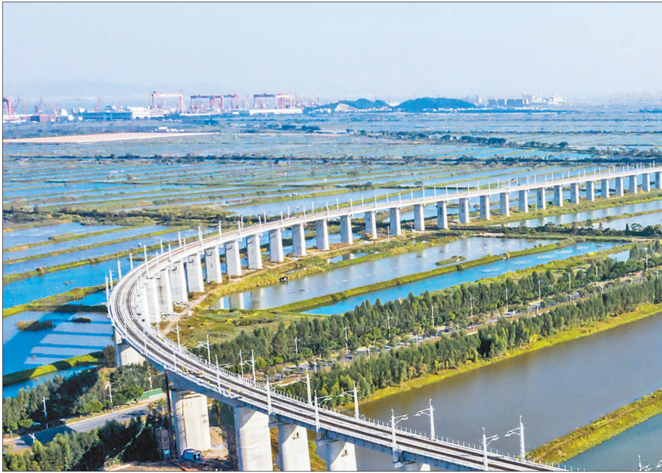
南沙港铁路2021年12月31日建成开通。南沙港铁路设计时速120公里，正线全长约88公里，线路自广州铁路瑶瑶所引出，途经江门、佛山、中山、广州，终至南沙港区。程远州 姜晓丹 杨胜摄影报道
