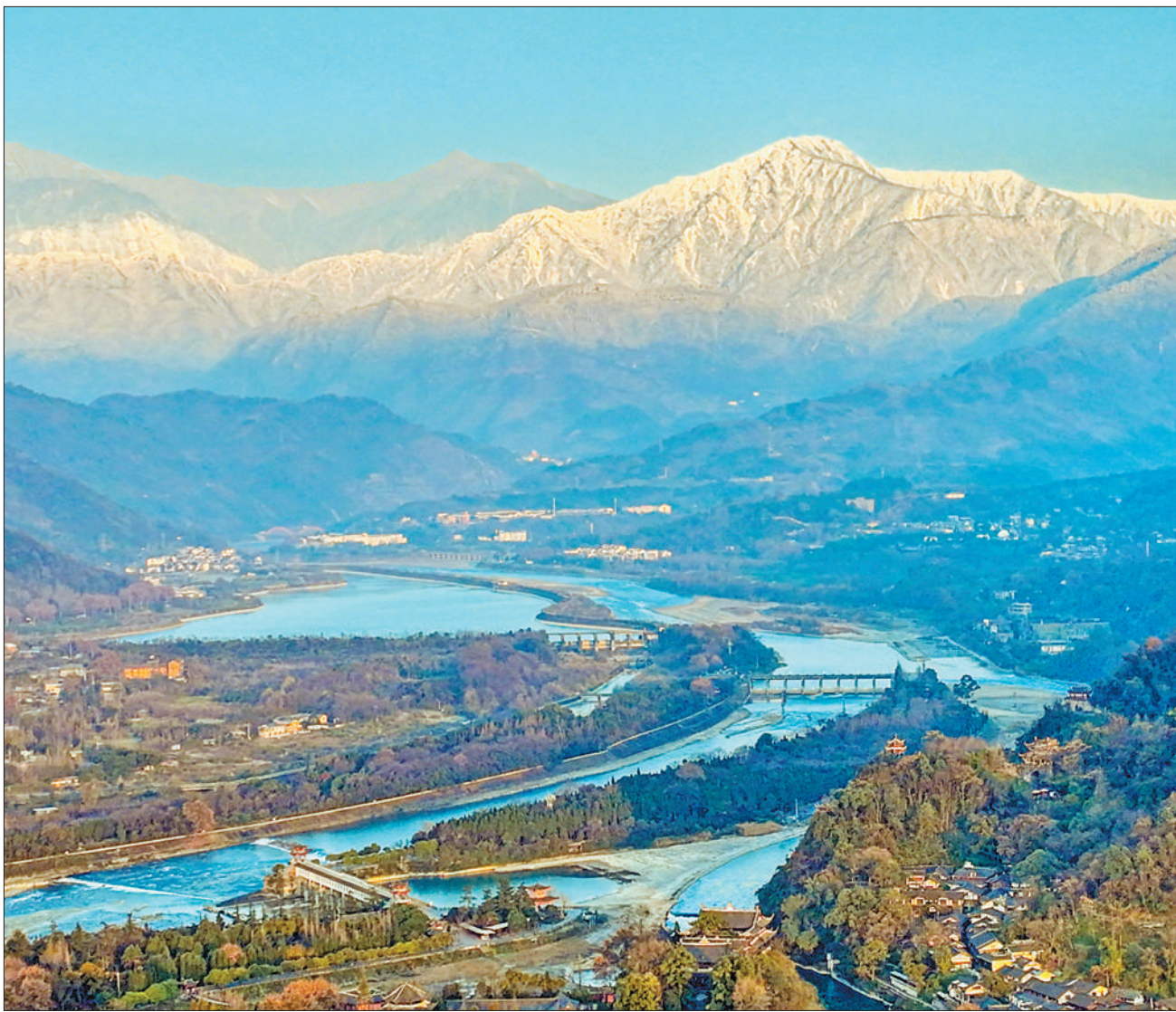
12月29日,四川都江堰水利工程在雪山映照下雄伟壮观,从山口奔腾而出的岷江水被形似鱼嘴的河堤一分为二。随着现代科技手段的运用,都江堰的防灾能力更强、灌溉面积更大、生命力更旺盛。历经2000多年岁月砥砺,都江堰水利工程仍然青春焕发。
