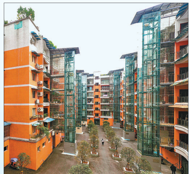
图①:工人在安徽省六安市春江公寓小区进行电梯安装。该小区加装电梯采用“企业垫资安装,政府给予补贴,业主有偿使用”模式,让老旧小区居民享受更好生活。田凯平摄(人民视觉) 图②:北京市海淀区北太平庄街道一居民楼完成旧楼改造加装电梯惠民工程主体施工。林晖摄(影像中国) 图③:居民从内蒙古自治区呼和浩特市玉泉区农科院小区一栋老旧居民楼加装的电梯内走出。丁根厚摄(影像中国) 图④:江西省赣州市赣县县城南社区井前家园,工人在焊接旧居民楼加装电梯钢结构外立架。朱海鹏摄(影像中国) 图⑤:上海市浦东新区潍坊九村老旧小区加装电梯项目在进行电梯吊吊装。沈春琛摄(影像中国) 图⑥:重庆市垫江县桂溪街道松林社区桂冠花园小区,老楼加装电梯后居民出入更方便。齐岚森摄(人民视觉)
