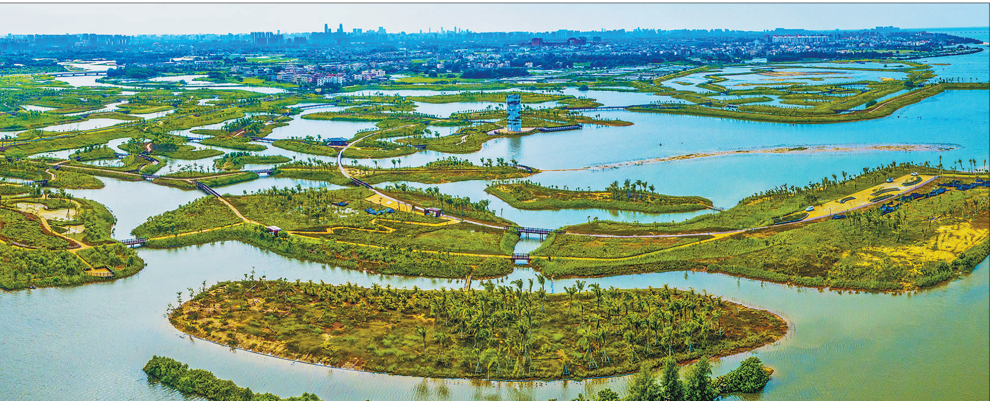
海南海口江东新区迈雅河区域生态修复项目通过退渔还湿、整合水陆空间、梳理路网和水网、种植不同种类的植物等，建成了一处环境优美的生态湿地公园。图为日前拍摄的海口江东新区迈雅河区域景象。
