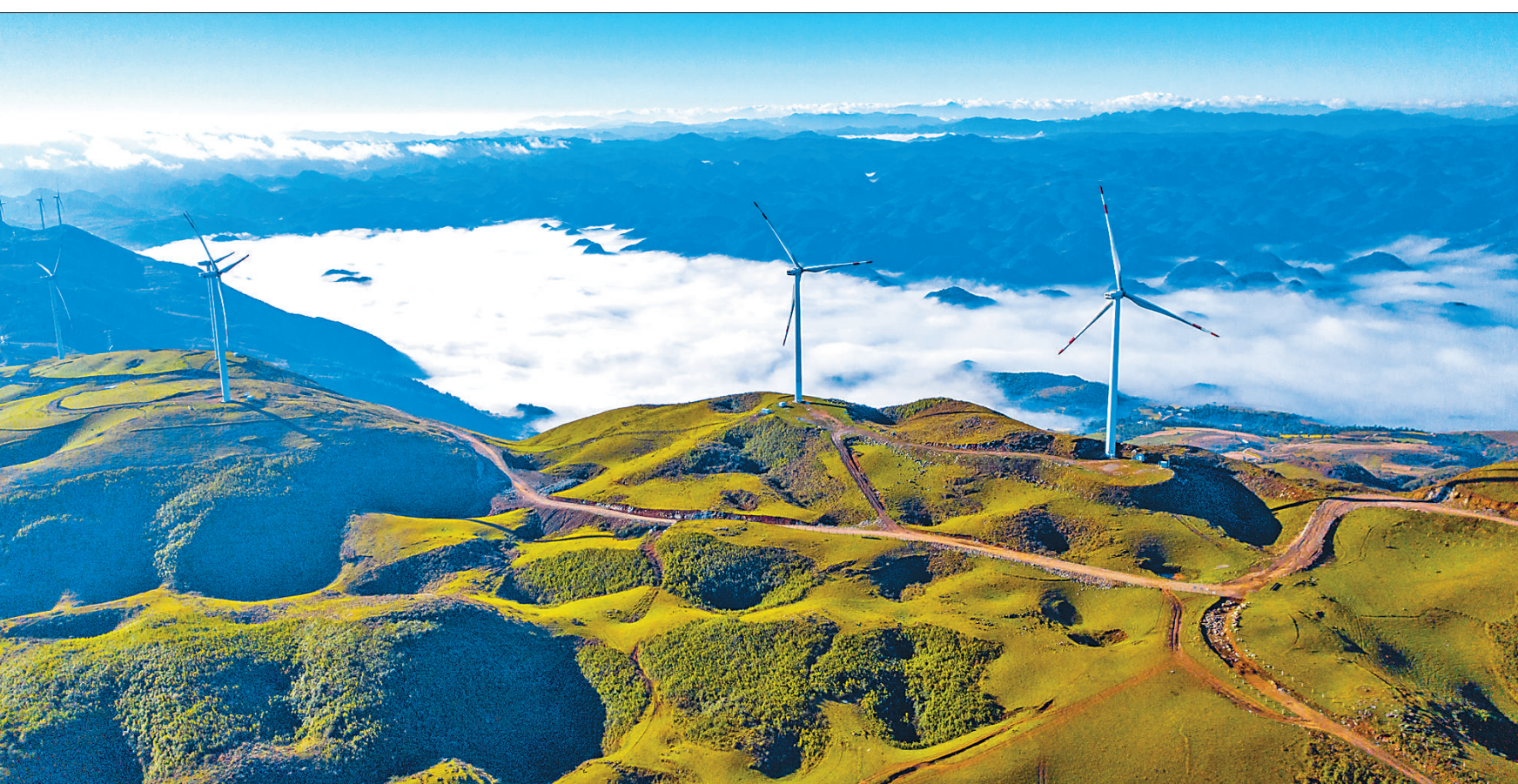
云南省文山壮族苗族自治州坚持山水林田湖草系统治理,采取人工种草、草地改良等综合措施,全面提升林草质量,推进石漠化综合治理。目前,当地草原综合植被盖度已达87.3%。图为文山州砚山县黑巴草场,风电设施矗立在绿茵上。
