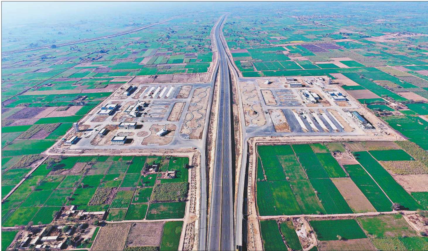
图为巴基斯坦卡拉奇至拉合尔高速公路第三标段项目鸟瞰图。
