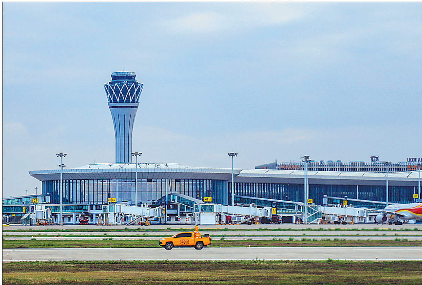
海口美兰国际机场新塔台于11月20日正式启用。新塔台高108米,共22层,是美兰国际机场南北双跑道投运的先导性核心工程,高出原塔台近42米,大大弥补了原塔台视野不佳的不足。海口美兰国际机场二期扩建项目计划于12月2日投入运营。
