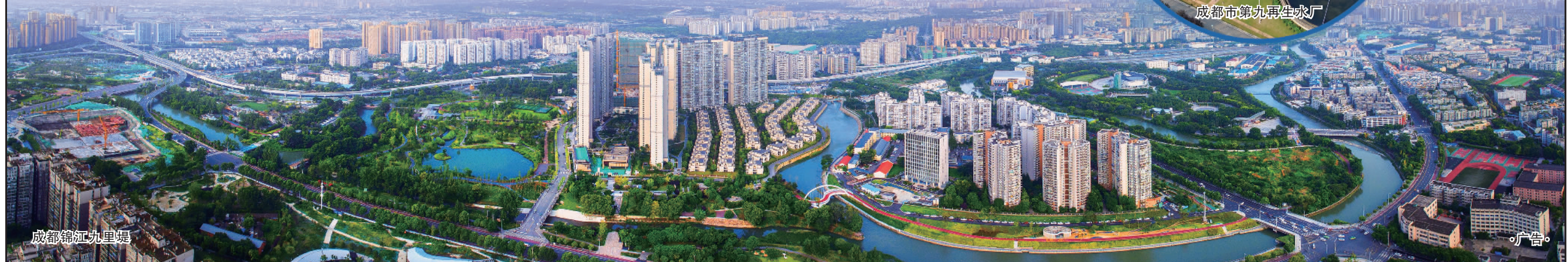
成都市第九再生水厂
