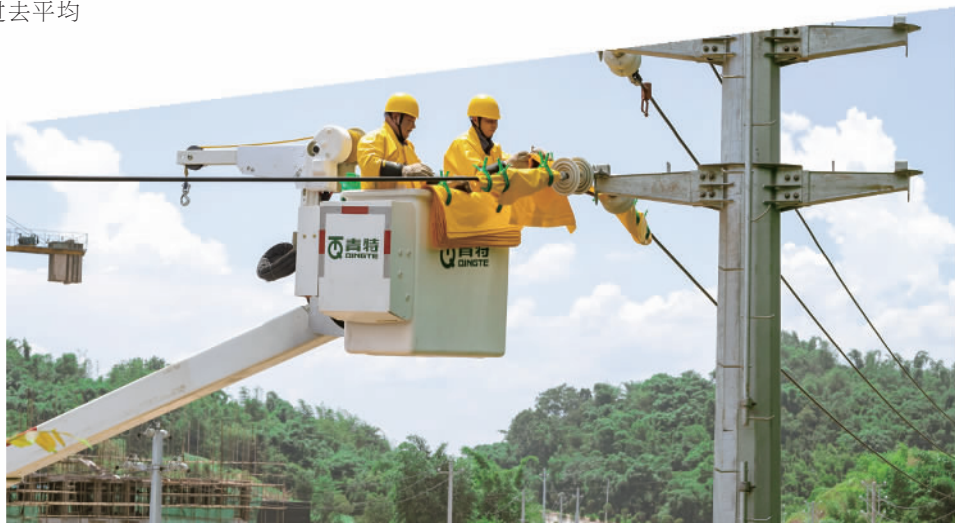
南方电网工作人员大力开展不停电作业,进一步提升供电可靠性
