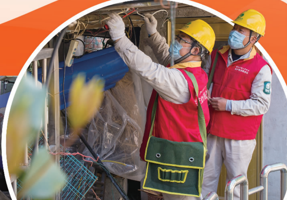
“繁星花”共产党员服务队队员在拆除存在安全隐患的老旧电线
