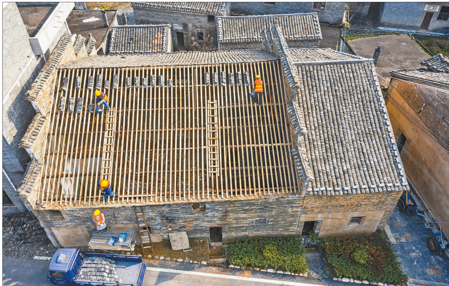
近年来,江西省吉安市吉水县按照“修旧如旧”原则,加强保护古建筑成片的传统村落。图为10月30日,工匠正在对吉水县桥镇洲村的一栋老屋进行换瓦修复。李福孙摄(人民视觉)
