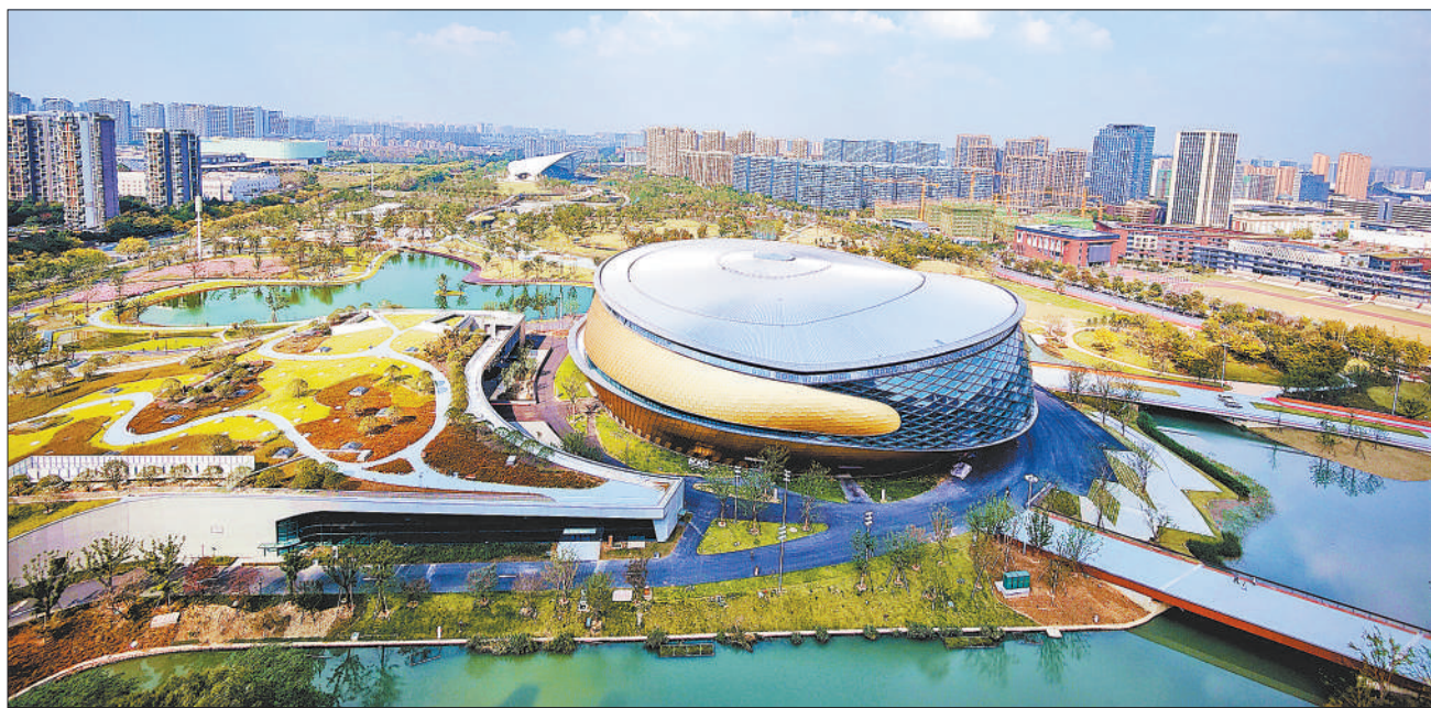
大运河亚运公园竣工
