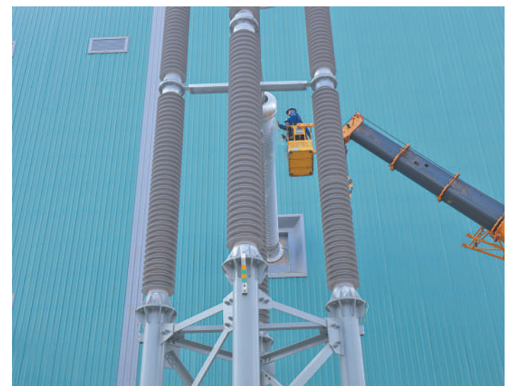
电力工人攻坚雅中换流站。
