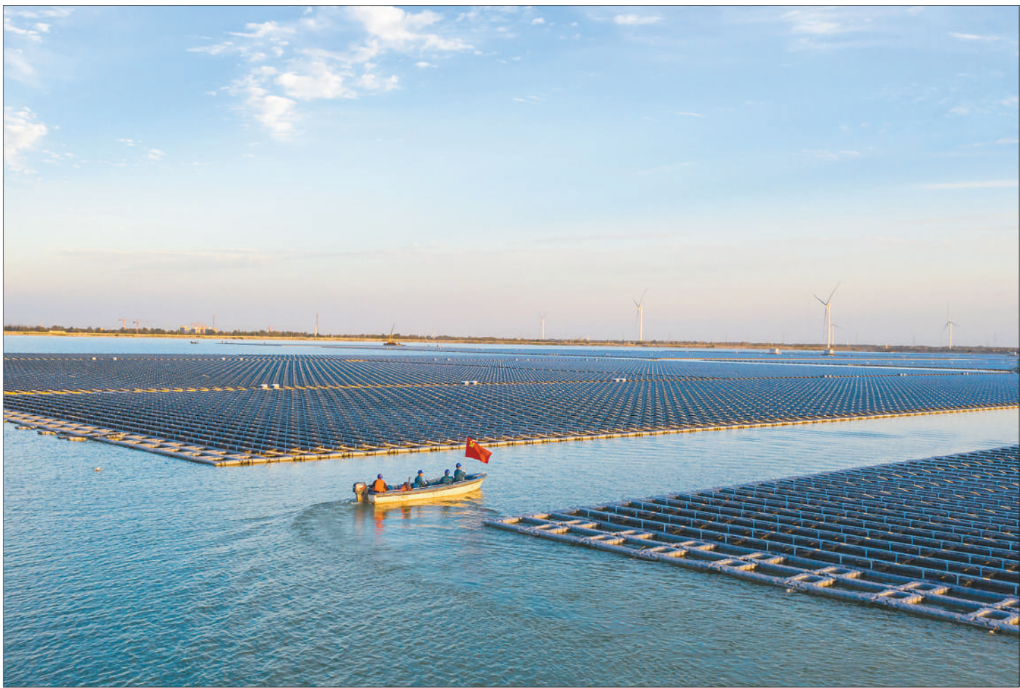
近日，山东德州丁庄华能光伏电站一期100兆瓦项目并网发电。该电站运用多项创新节能环保技术，项目全部建成后，可提供清洁能源4.2亿千瓦时，节约标准煤20.5万吨。图为工作人员在排查安全隐患，确保项目稳定运行。宋伟龙摄(影像中国)
