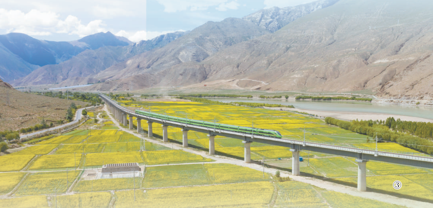
图③:西藏自治区山南市,一列动车组行驶在拉林铁路上。
