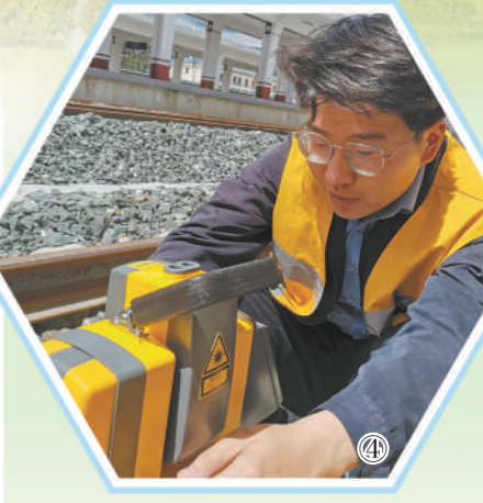
图④:张腾在铁路施工现场。
