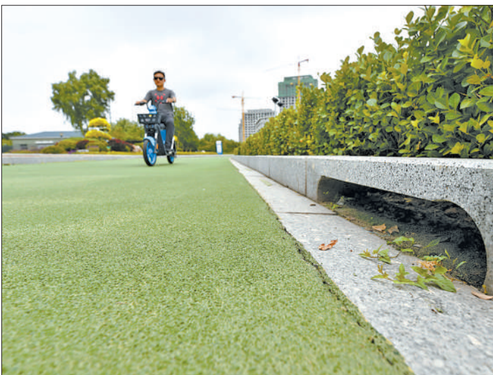
右图：河北迁安在街道设置路缘石开口，便于排水。
