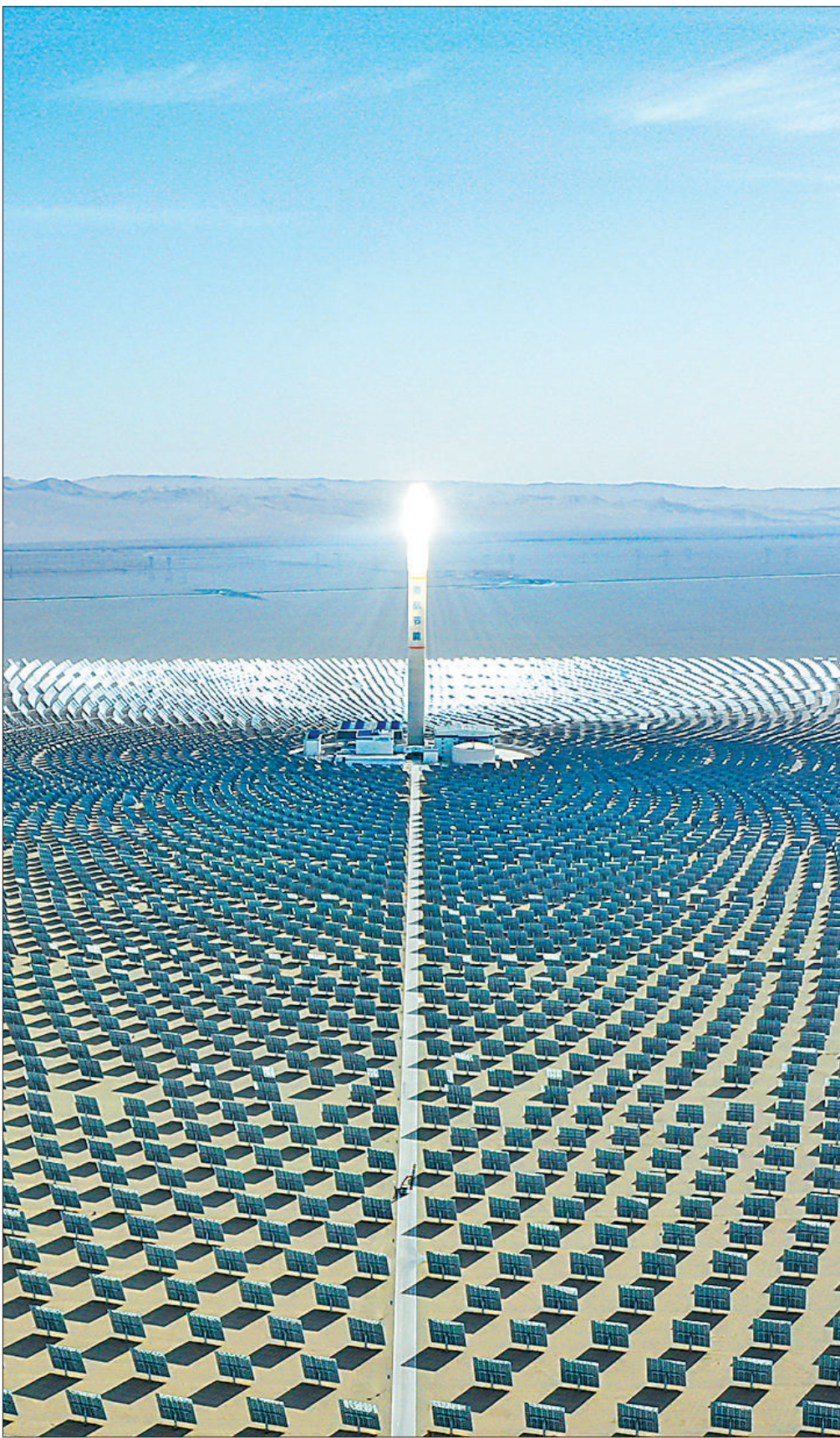
被称为“超级镜子发电站”的首航高科敦煌100兆瓦熔盐塔式光热电站是国家首批光热发电示范电站之一。依托甘肃省敦煌市丰富的太阳能资源,该项目年发电量达3.9亿千瓦时,每年可减排二氧化碳35万吨。
