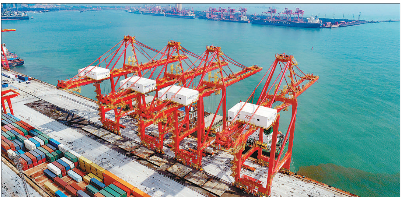
10月9日,全球领先的顺岸开放式全自动化集装箱码头在山东日照港投产运营。该码头首次将“北斗+5G”和国产码头操作系统应用到作业全过程,实现了厘米级精度操作。图为日照港顺岸开放式全自动化集装箱码头。张进刚摄(影像中国)
