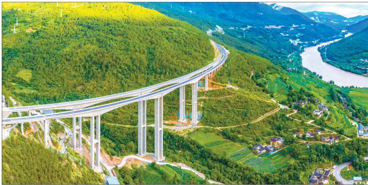
9月29日,云南香格里拉至丽江高速实现双向全程通行。香格里拉是国家支持高原地区经济社会发展的重要支撑项目,是云南目前海拔最高的高速公路,是迪庆藏族自治州第一条高速公路。项目全长140.305公里,全线设桥梁120座、隧道26条,桥隧比高达55%。
