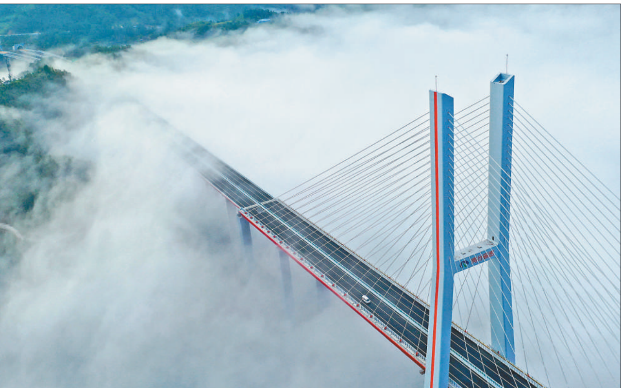
9月27日清晨,贵州省贵定县云雾镇都(匀)安(顺)高速公路云雾大桥,云雾缭绕。云雾大桥今年6月28日通车运营,是都安高速全线控制性工程,也是“十四五”期间贵州通车的第一座高速公路特大桥。
