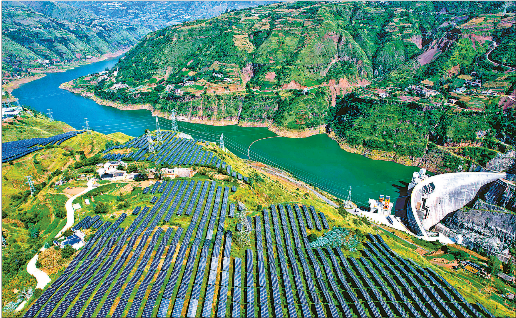
9月24日，在贵州省威宁彝族回族苗族自治县玉龙镇拍摄的象鼻岭水电站和农光互补基地。象鼻岭水力发电总厂是一个多能互补的清洁能源开发基地，建设有水电站和光伏电站。当地在光伏电站种植花椒和石榴等经济作物，提高土地利用效率，增加产出，实现经济效益和生态效益的双丰收。
