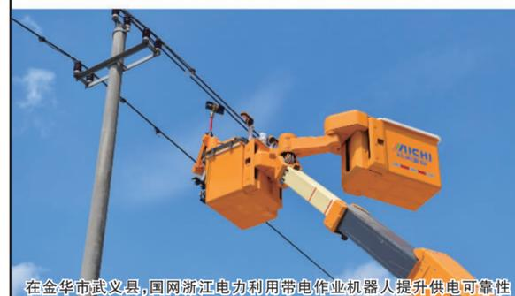
在金华市武义县，国网浙江电力利用带电作业机器人提升供电可靠性
