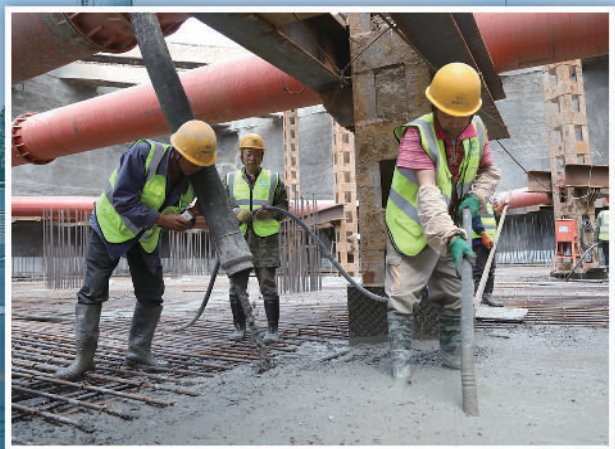
施工人员对建设中的地铁车站进行顶板浇筑
