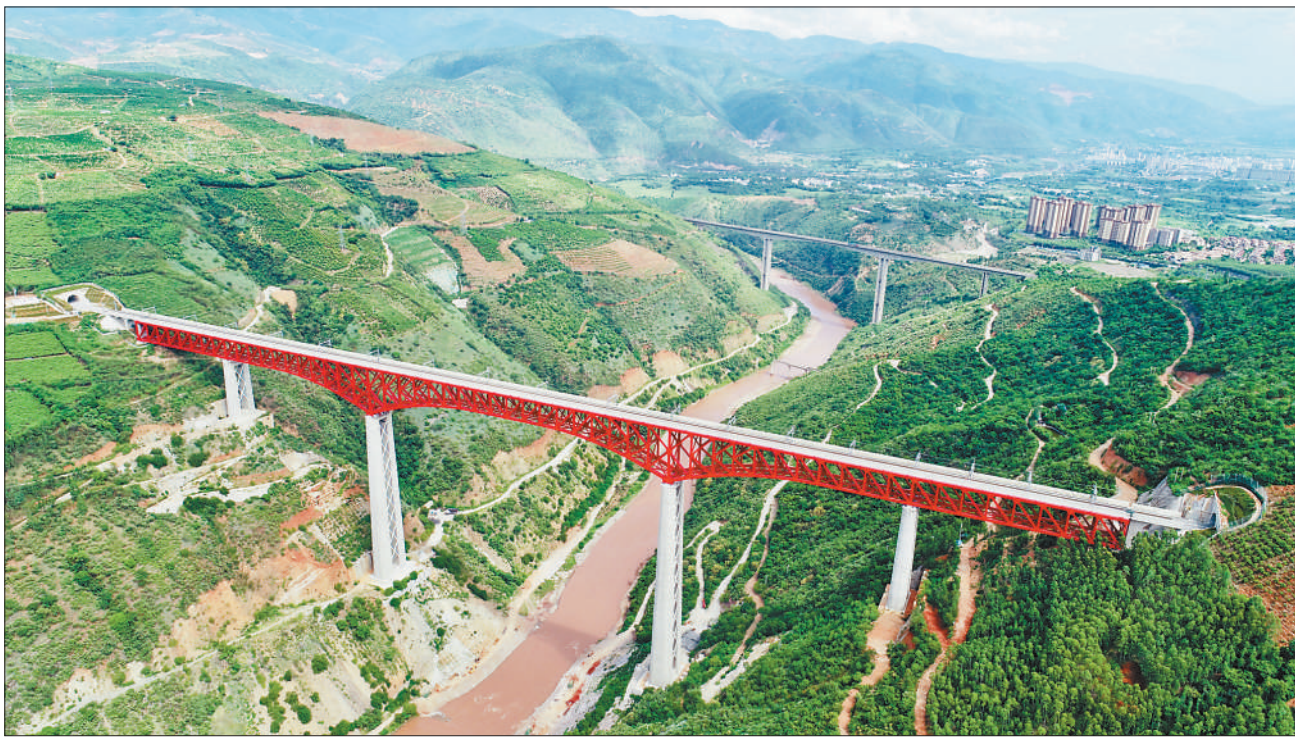
9月15日,中老铁路全线重点控制性工程元江特大桥全面建成。
