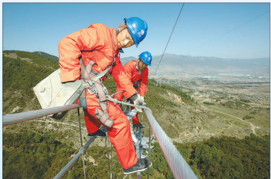
图①：中国石油新疆油田分公司吉庆油田作业区，钻井工人正在推钻杆。张昀摄(影像中国) 图②：河北省唐山市曹妃甸区新天LNG(液化天然气)项目二期工程工地上，工人在施工。新华社记者 朱旭东摄 图③：云南省昆明市禄劝彝族苗族自治县和四川省凉山彝族自治州会东县交界的金沙江河道上，乌东德水电站蔚为壮观。新华社记者 江文耀摄 图④：江西省赣州市兴国县茶园乡十八排风电场，风电机组群耸立云端。邱新生摄(影像中国) 图⑤：青海中控太阳能发电有限公司建设运营的德令哈50兆瓦塔式储能光热发电项目。本报记者 雷声摄 图⑥：四川省凉山彝族自治州布拖县先锋村，白鹤滩水电站送出工程，施工人员在500千伏NC333—NC334号塔之间安装间隔棒。田海摄(影像中国)
