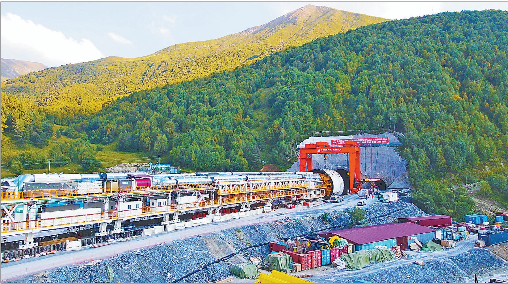
投入使用的全球最大直径全断面硬岩掘进机“高加索号”日前在格鲁吉亚亚里瓦建设完毕。中国中铁隧道局集团供图(新华社发)
