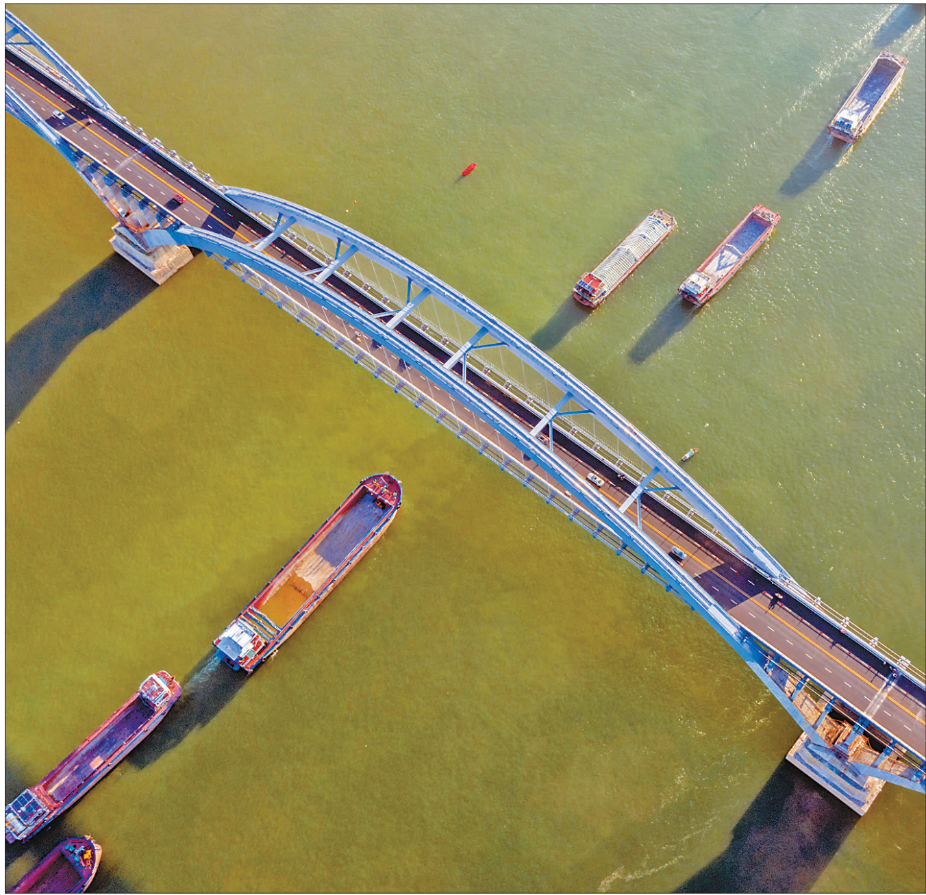
9月1日，广西梧州市高旺大桥上层桥面开放交通。高旺大桥的建成，将使梧州市的有关片区相互连接，有效减轻云龙大桥、西江大桥的交通压力，对带动当地经济发展具有重要意义。图为9月4日，俯瞰高旺大桥。
